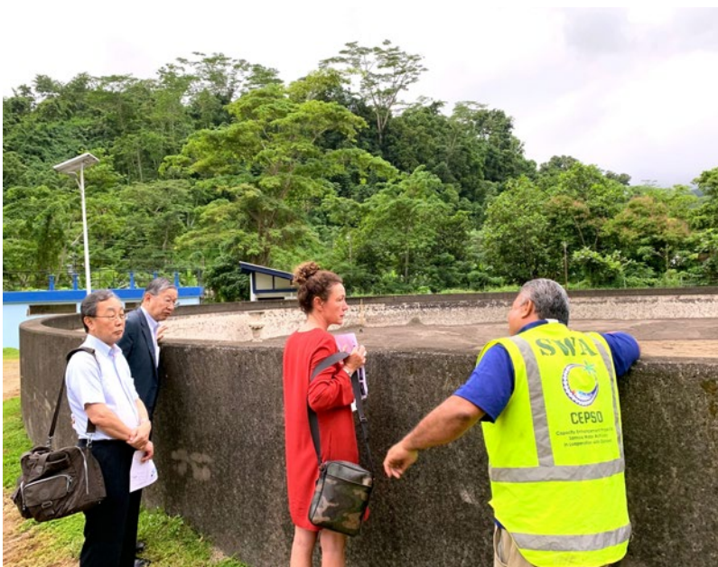
現地の上水道施設を視察する一行
