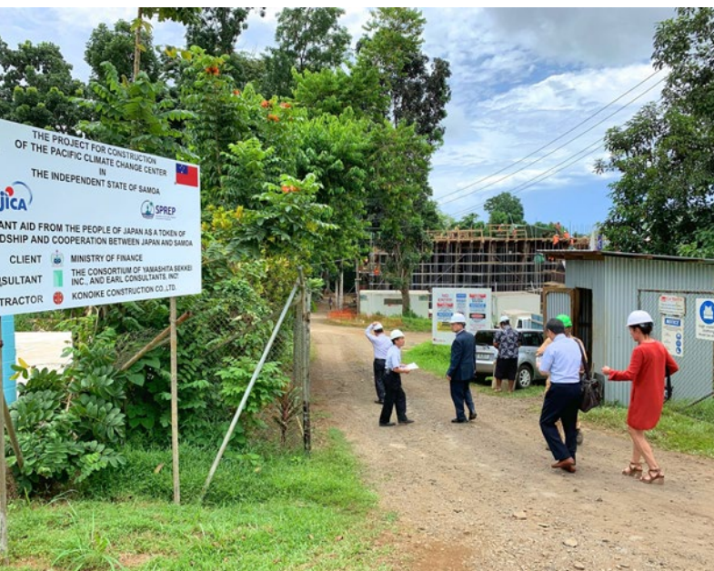
太平洋気候変動センター建設現場の視察
