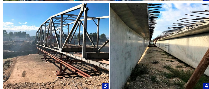
1. 橋梁掛け替えプロジェクト 新線橋梁側の全景図 2. 橋梁掛け替えプロジェクト 定礎式に参加のモイーズ大統領（当時）による挨拶 3. 橋梁製作ヤード全景 4. 橋梁プレストレスト・コンクリート桁 5. 橋梁掛け替えにあたり 既存の鋼橋撤去工事を実施（クロワ・デ・ミッション）
